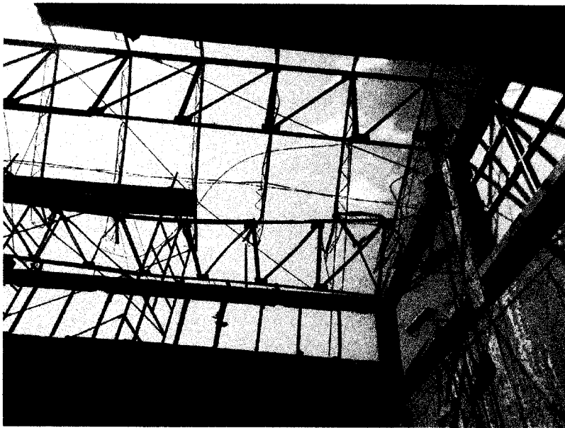
Imagen 014 – Desmontaje de estructura metálica en mal estado.
