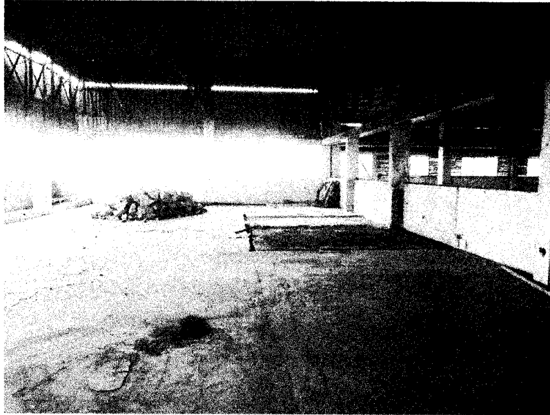
Imagen 003 – Demolición de piso de comedor en segundo nivel
