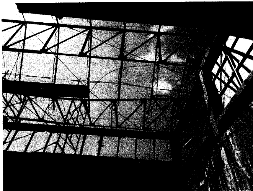
Imagen 10 – Desmontaje de estructura metálica en mal estado.
