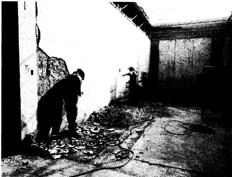
Imagen 002 – Picado de muros interiores de 4.00 mts. de altura
